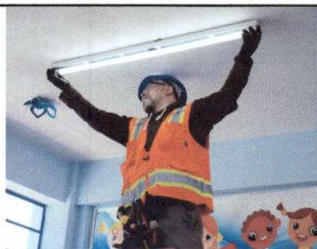
Foto 3: Reparación de cableado electrico.
