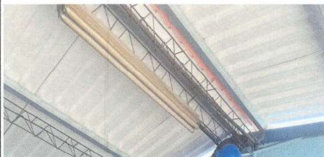
Foto 3: Sustitución de estructura de techo.
