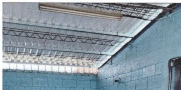
Foto 4: Sustrucción de lamparas.
