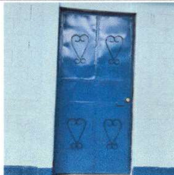
Foto 2: Sustitución de puertas de metal..
