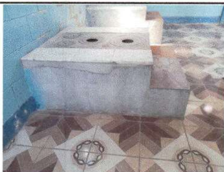
Foto 5: Instalación de azulejo en estufa rural.
