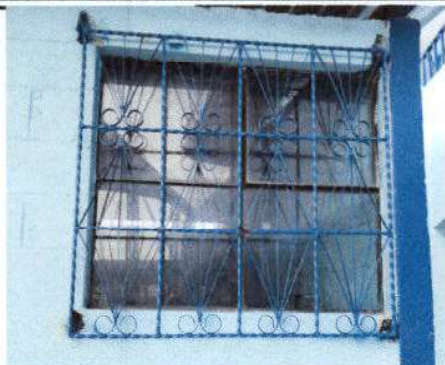
Foto1: Sustitución de balcones de metal.
