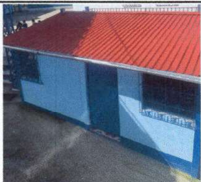
Foto 1: Sustrucción de lamina troquelada calibre 26.
