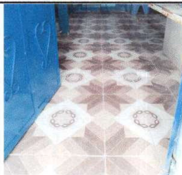
Foto 4: Sustitución de ceramico de piso.
