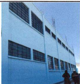
Foto 5: Mejoramiento de pinturas en muros.
